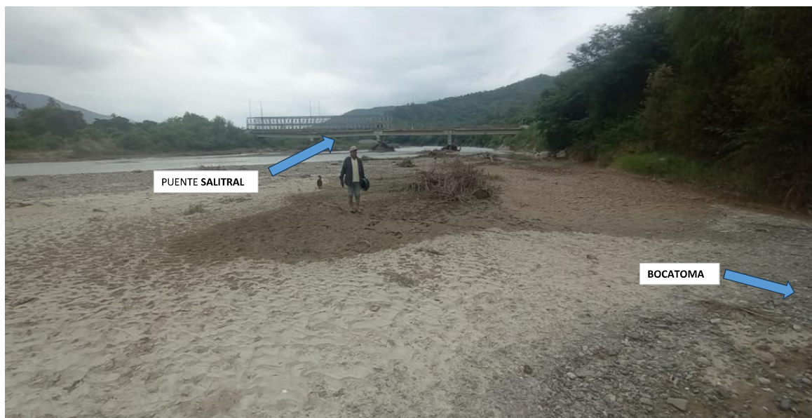
Figura N° 01: Se observa la colmatación en la margen izquierda del cauce del río Piura aguas abajo del puente Salitral
