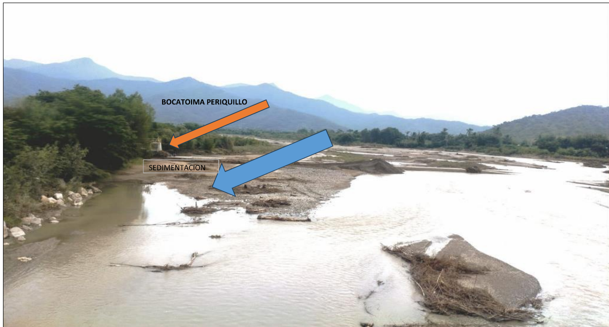
Figura N° 03: Se observa la colmatación en la margen izquierda del cauce del río Piura obstruyendo ingreso del agua a la bocatoma Periquillo.
