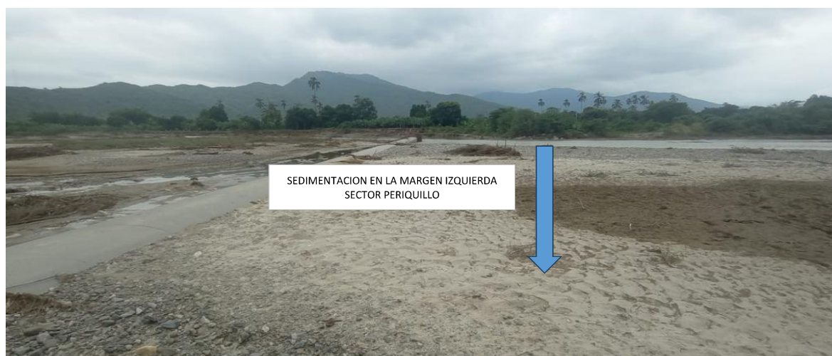
Figura N° 02: Se observa la colmatación en la margen izquierda del lecho del río Piura aguas abajo del puente Salitral
